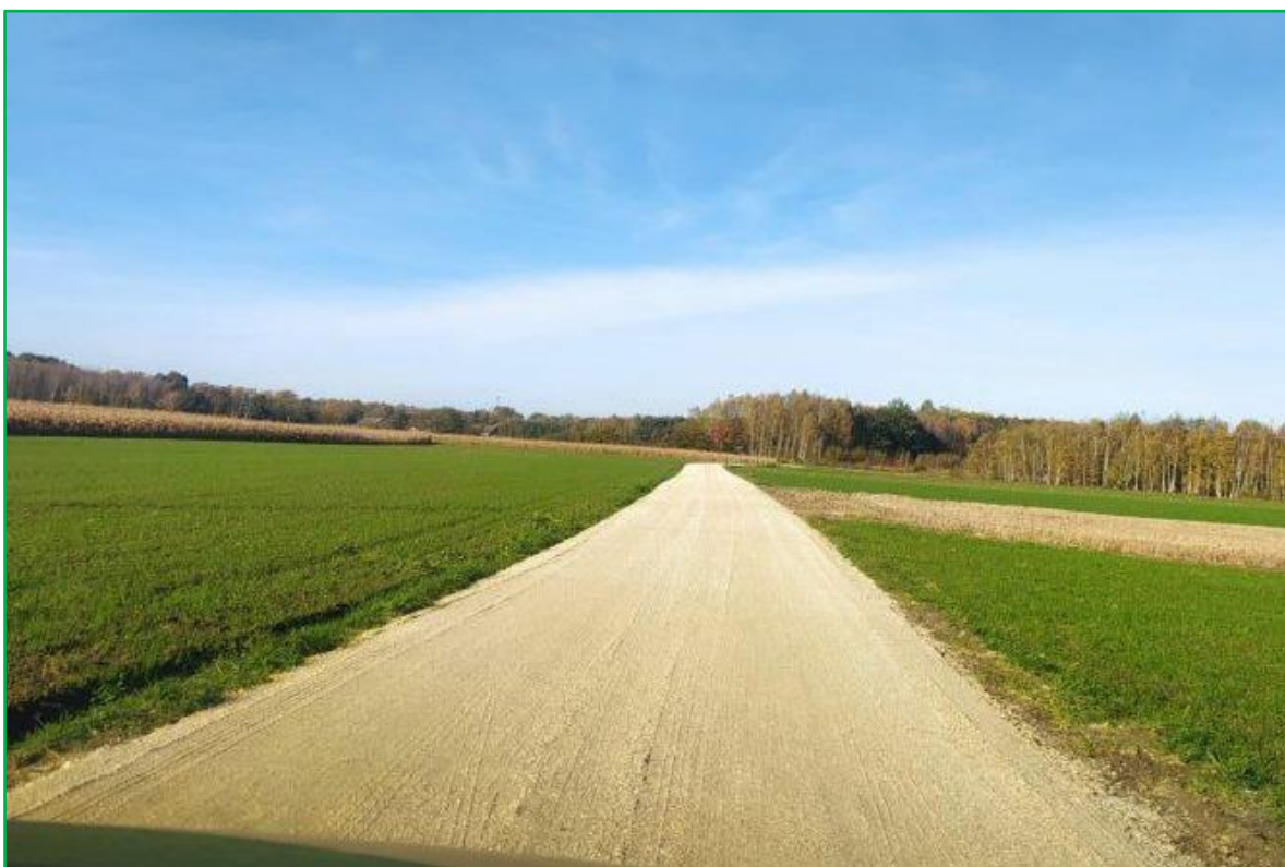
Zdjęcie 2. Zmodernizowana droga dojazdowa do gruntów rolnych w m. Szafranów
