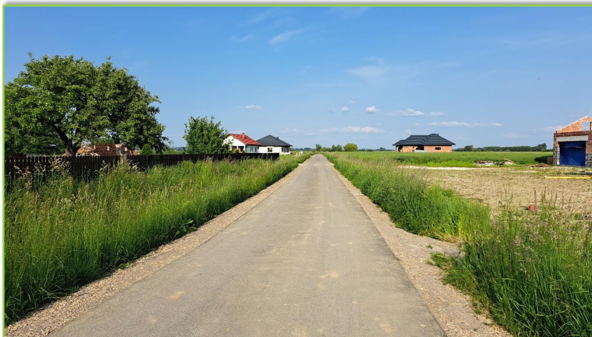
Zdjęcie 1. Zmodernizowana droga dojazdowa do gruntów rolnych w m. Czermin
